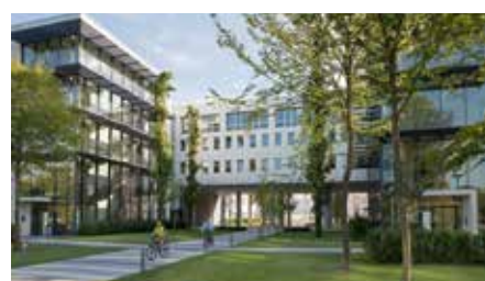
Neue Baufortschritte am Business Campus
